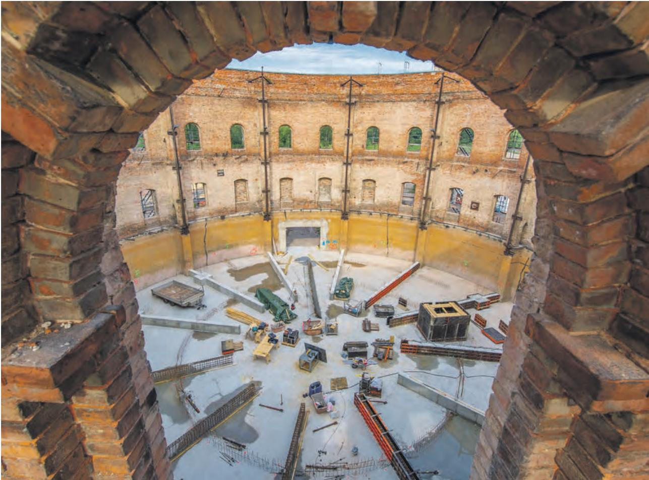
Die Arbeiten am neuen Planetarium im ehemaligen Gasometer am Holzplatz schreiten weiter voran. Derzeit folgt die Bewehrung zur Verstärkung der unteren Bodenplatte. Die Fertigstellung des Planetariums ist für Mitte 2021 vorgesehen. Foto: Thomas Ziegler
